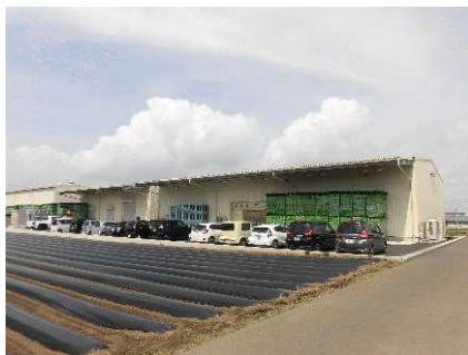
新設した保管庫兼低温倉庫
