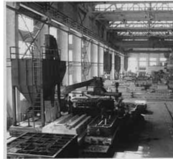
増設中の鋳物工場（中国）
