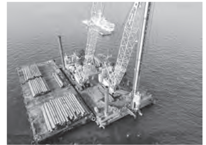
くい打ち工事の様子
