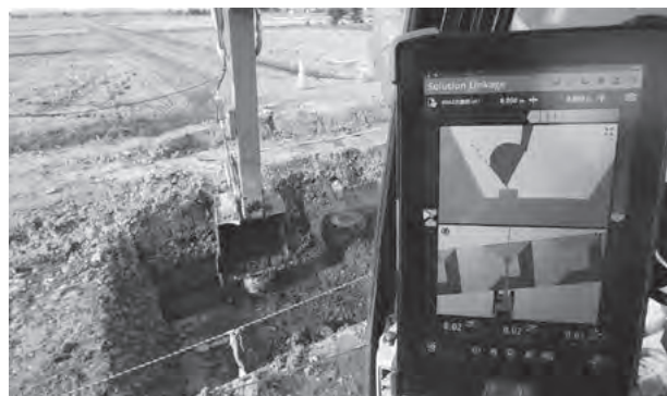
㈱砂子組によるICT建機を使った道路工事
