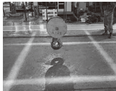
クレーンの危険ゾーンを光で明示
