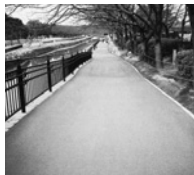
防草土で舗装した歩道
