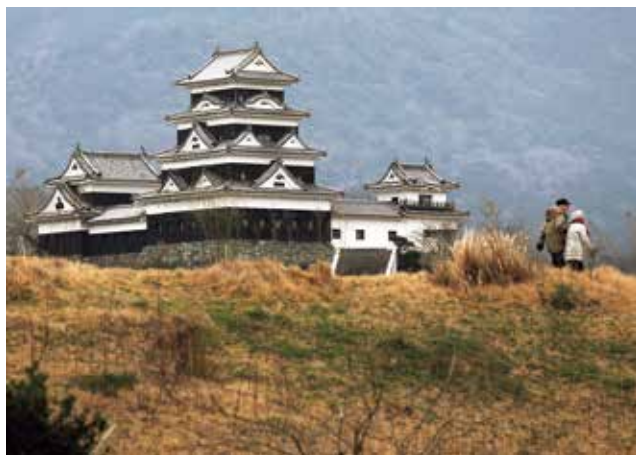
歴史と伝統文化の象徴である大洲城。市民参加のもと天守の木造復元が実現し、地域の誇りを取り戻す拠点となった
