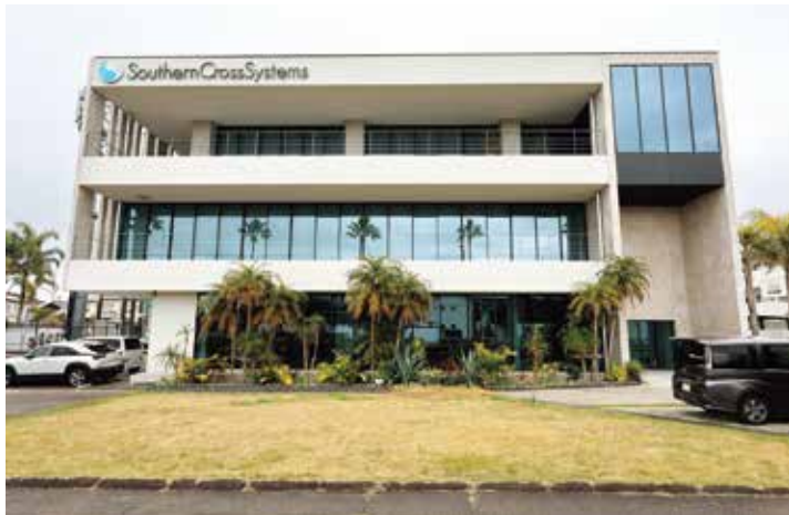
サザンクロスシステムズ宮崎本社の社屋。宮崎空港に近い国道220号沿いの立地で、社屋自体の宣伝効果も高く、採用活動などに効果をもたらしている
