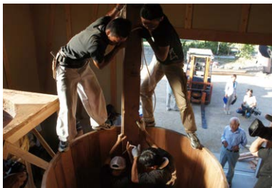
5 底板を打ち込む。完成後、木桶に水を入れて漏れないか確認する
