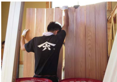
2 側板を合わせて円形にし、鉄製の輪で仮締めして木桶の形にする
