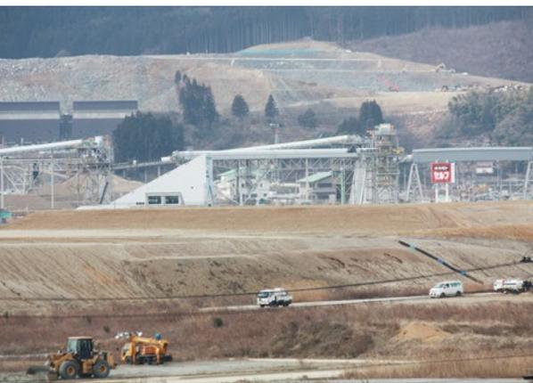
工事現場に渡された巨大なベルトコンベヤー
