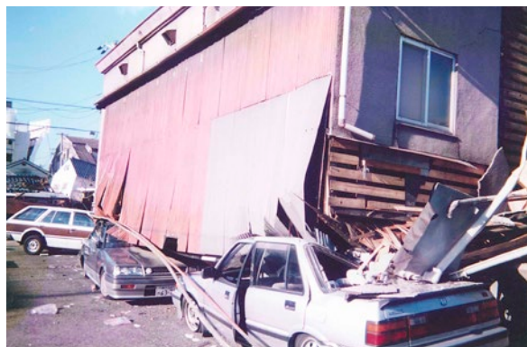
阪神・淡路大震災を受けて倒壊した旧工場
