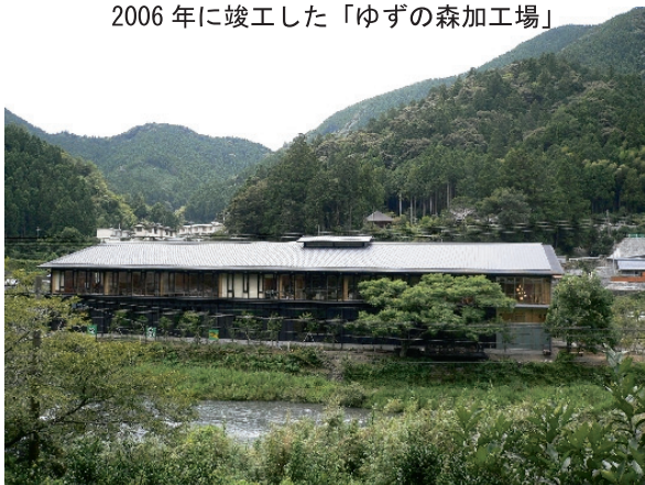
2006年に竣工した「ゆずの森加工場」
