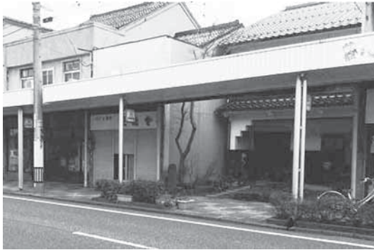
図-5 商店街の中の住宅
