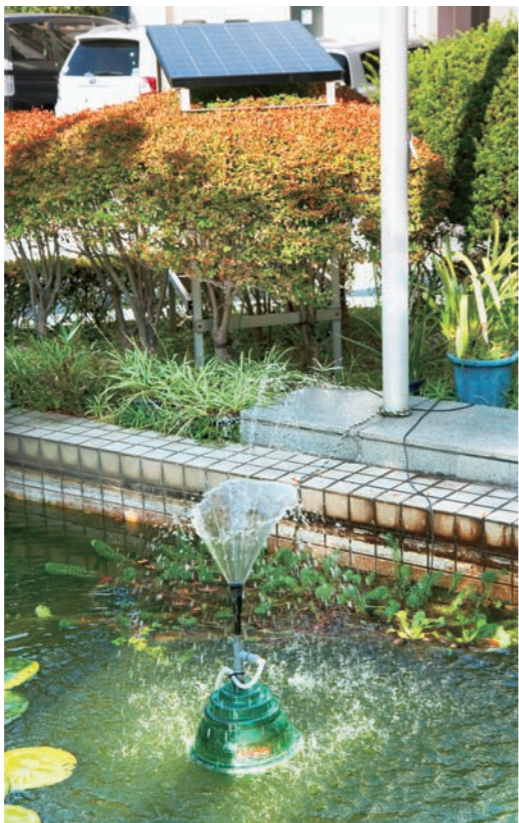
ソーラーパワーで動く噴水(写真上部が太陽光パネル)。屋上のソーラーシステムとともに2009年「かながわ新エネルギー大賞」を受賞。それまでは金魚のために水道水を流しっぱなしで年間20万円の水道料金がかかっていた。
