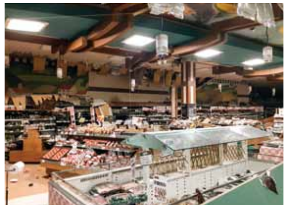
区画内すべての天井破損や陳列棚倒壊
