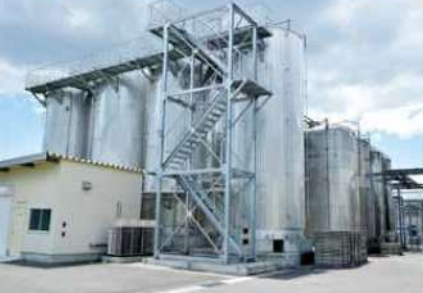
被災当時、発酵タンクから流出したもろみ(上)と、9カ月後に修復された現在の発酵タンク(下)
