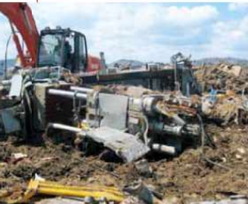
被災当時の本社金型工場内部（上）と、津波で流失した茨田工場の跡地（下）
