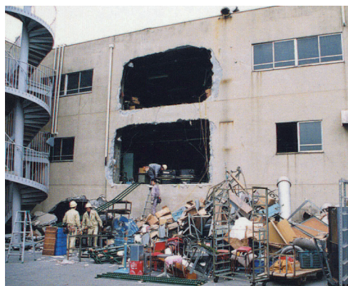
震災直後の工場（左）と、復興に向け、建物の壁に穴を開け、使える機材を搬出する様子（右）
