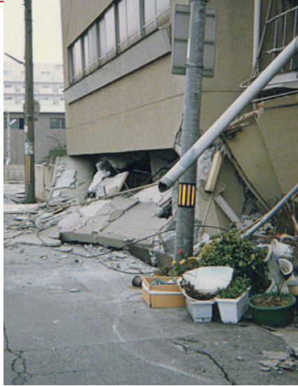
現在の本社社屋（左）と1階部分が押しつぶされた震災直後の本社社屋（右）
