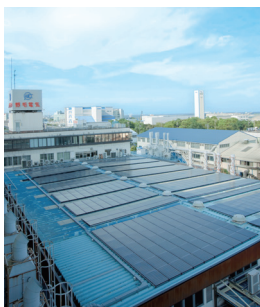
【表紙写真】 株式会社野毛電気工業が2009 年に導入したソーラーシステ ム。使用電力 1,200kW のうち 100kW を発電する。 (特集 P3-6)
