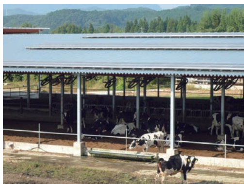
屋根に太陽光パネルが設置された畜舎
