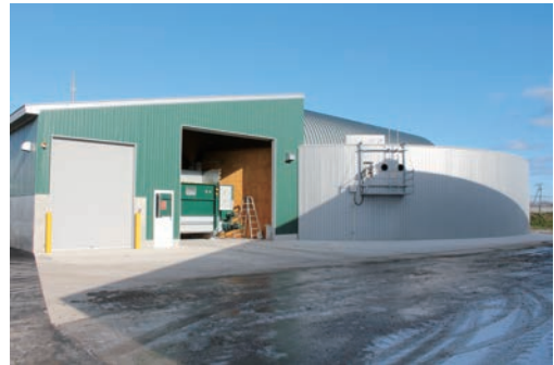
2013年に完成したバイオガスプラントは順調に運転中
