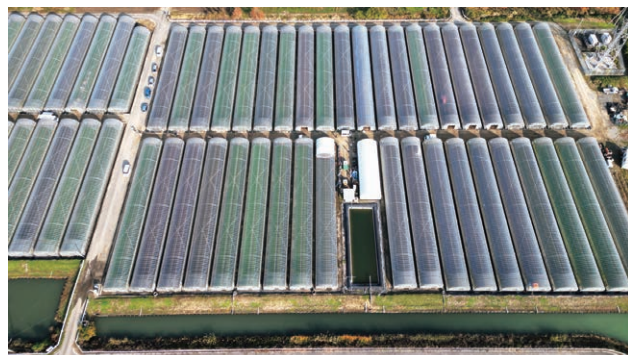
ハウスが98棟並ぶ。作業場近くに休憩所やトイレを設置。（10ページ2点写真提供：神埼市・日之出印刷株式会社）
