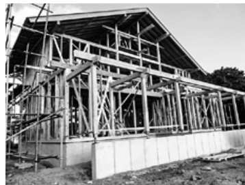
韓国平澤市に建設された県産材の木造軸組構法のモデルハウス
