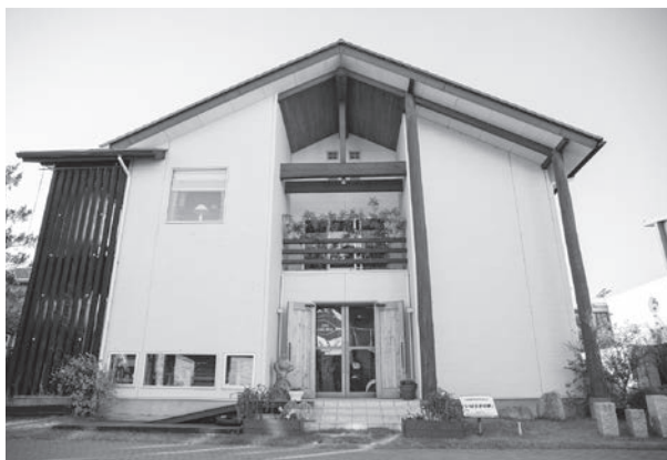
茨城県南木造住宅センター「いばらぎの家」モデルハウスは地産地消のシンボル。創業は1976年。一貫して県産木材を使用。県内には木材を扱える職人がまだ健在だという
