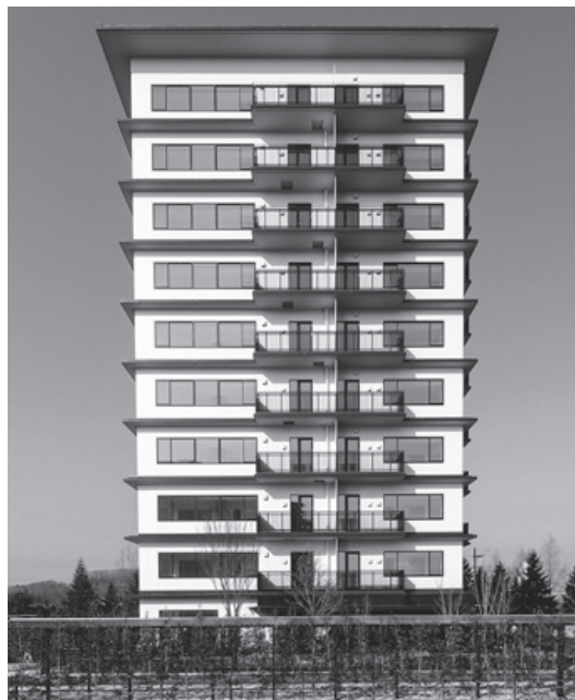
上：燃え代層と燃え止まり層、荷重支持部の3層構造になっている「燃え代層」 下：日本初の中高層木造建築「PARK WOOD高森」。燃え代層の柱を約17立方メートル使用している。
