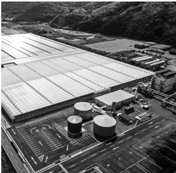
野菜生産ハウスおよびバイオマス発電設備
