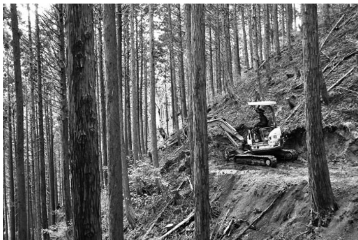
写真1 小型バックフォアで作業道を開設する様子
