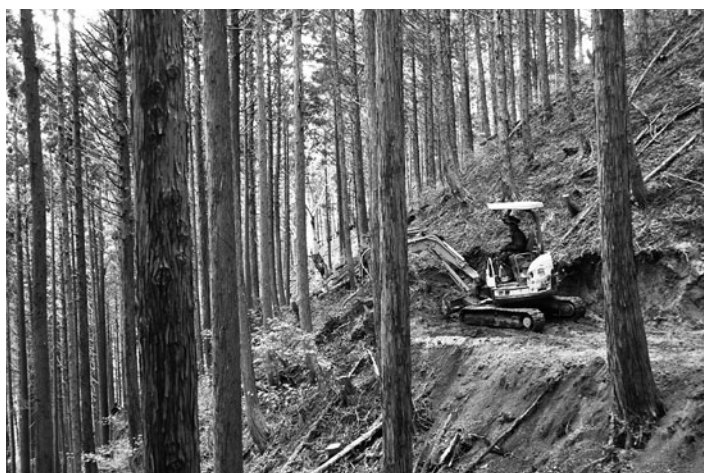
写真1 小型バックフォードで作業道を開設する様子
