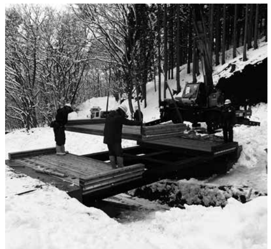
写真4 CLT床版を用いた林道橋 (架設) (秋田県仙北市)
