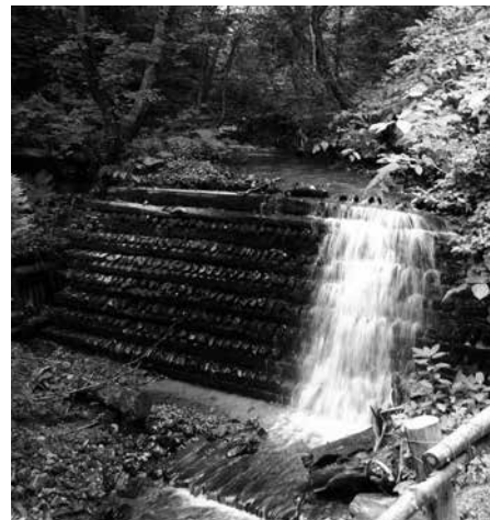
写真6 1954年に建設された木製ダム(ヒバ材) (青森県五所川原市坪毛沢)
