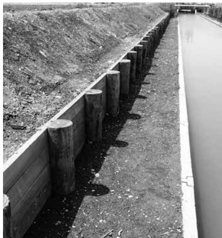
写真8 クリーク護岸の木杭柵工法の試験施工
