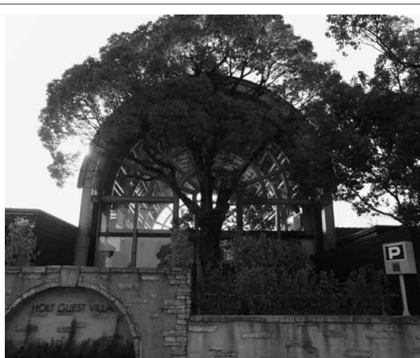
レストラン「ホルト」。湾曲大断面集成材を利用したホールが特徴的
