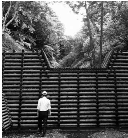
写真7 校倉式木製治山ダム (東北森林管理局由利森林管理署内)
