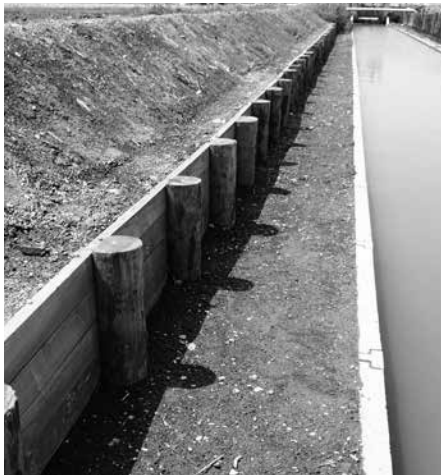
写真8 クリーク護岸の木杭柵工法の試験施工
