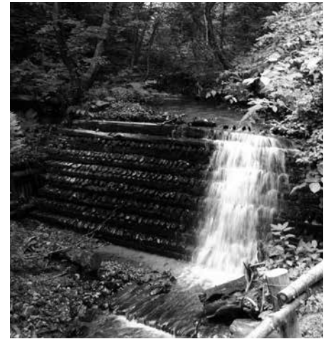
写真6 1954年に建設された木製ダム(ヒバ材) (青森県五所川原市坪毛沢)
