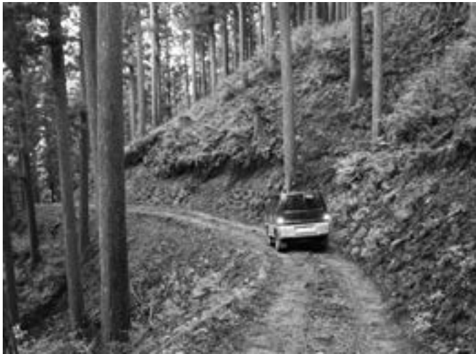
急傾斜地に作られた森林作業道
