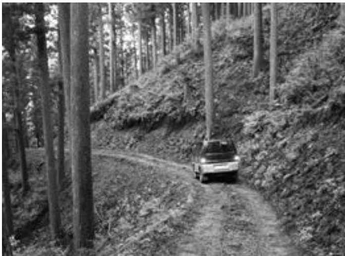
急傾斜地に作られた森林作業道
