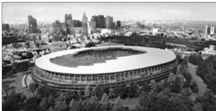
写真: 大成建設・梓設計・隈研吾建築都市設計事務所JV作成/JSC提供
