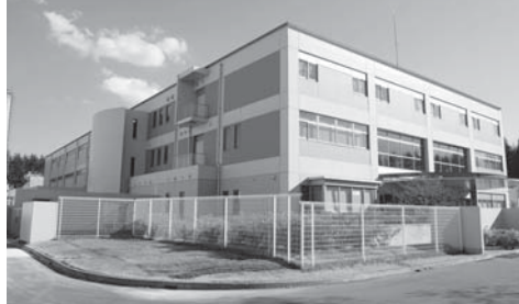
動物衛生高度研究施設(動物衛生研究所提供)
