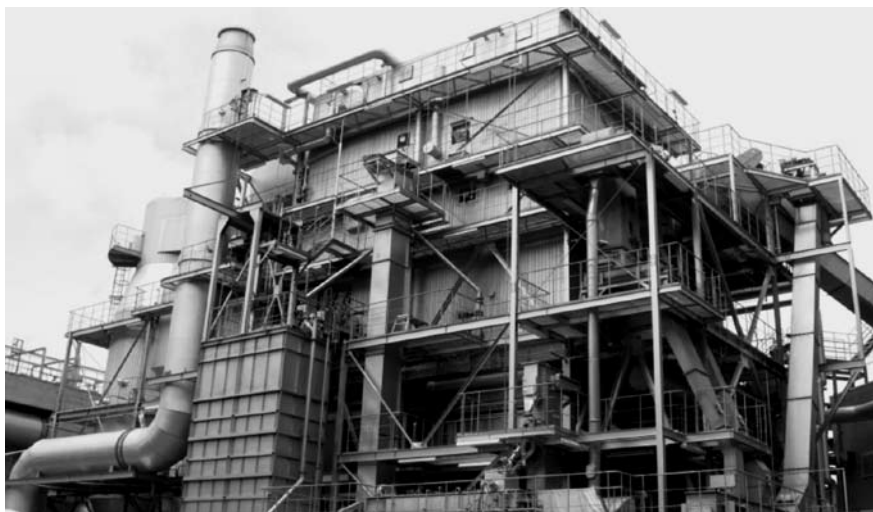
畜ふん発電ボイラー(2号機)の外観
