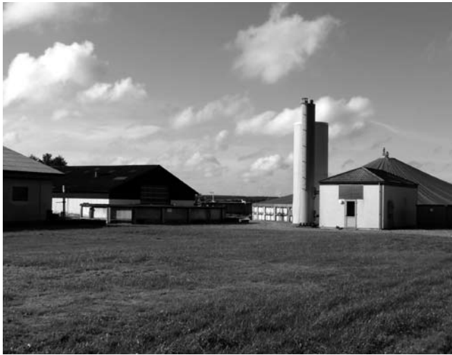
養豚農場に設置されたバイオガスプラント
