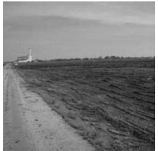
山元町高瀬地区巨理清掃センター付近 復旧前(上)、復旧後(下) (陸上自衛隊提供)
