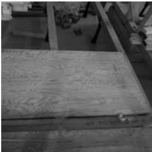
床下地に使われる国産カラマツを使った厚物構造用合板
