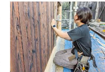
■施工の様子。リフォームやリノベーションにも力を入れ、幅を広げていきたい
