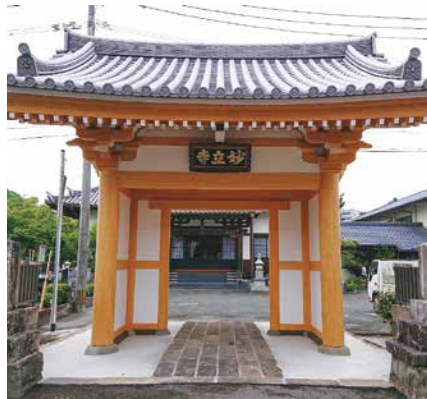
熊本地震で倒壊した「妙立寺」の山門を 郷原組が新築。
