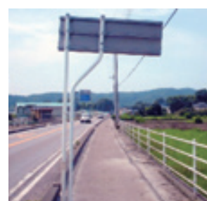
防草工事施工後(3年経過)
