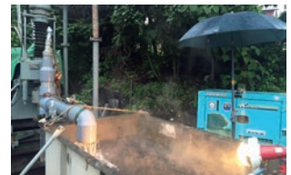
工事中の温泉井戸
