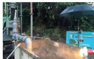
工事中の温泉井戸
