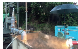
工事中の温泉井戸
