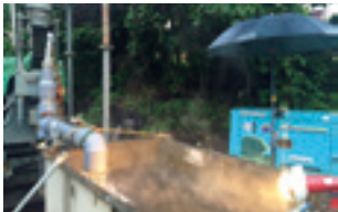
工事中の温泉井戸
