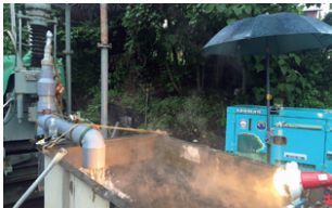
工事中の温泉井戸
