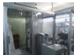
同社の高潔浄度クリーンブース
