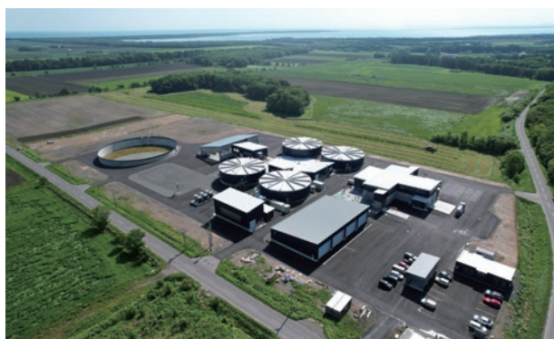
バイオガスプラントの全景
