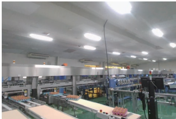
更新されたパッキングラインの一部
