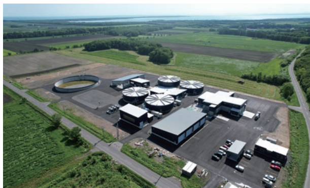
バイオガスプラントの全景
