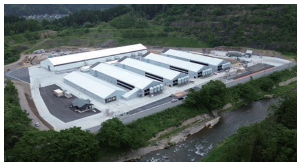
新農場では鶏糞の堆肥化処理施設も整備
