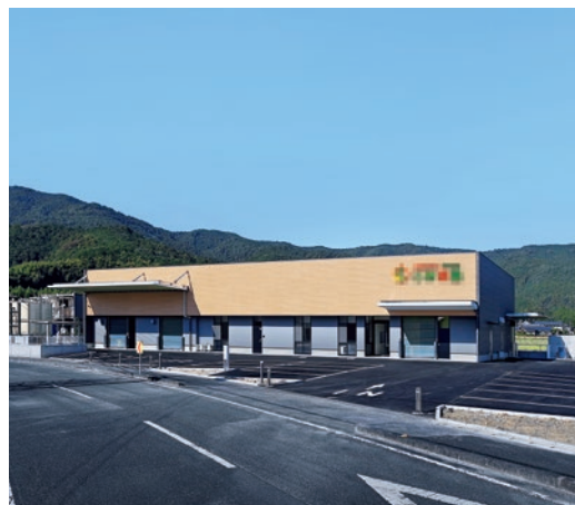
稼働を開始した新工場の外観
