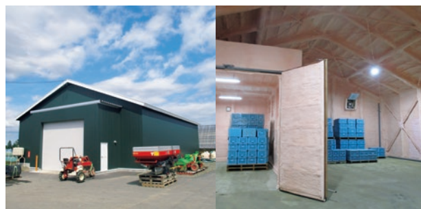
貯蔵保管庫の外観・内観
