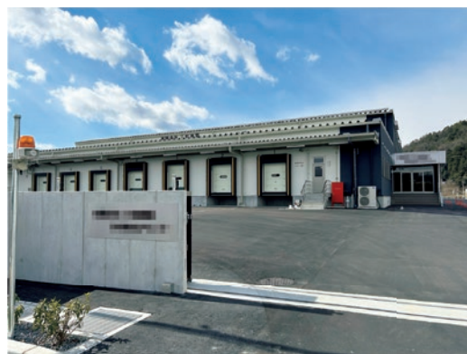
稼働を開始した新GPセンターの外観
