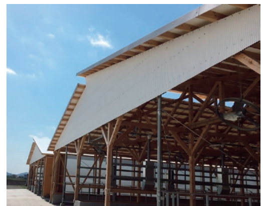
建設が進む牛舎
