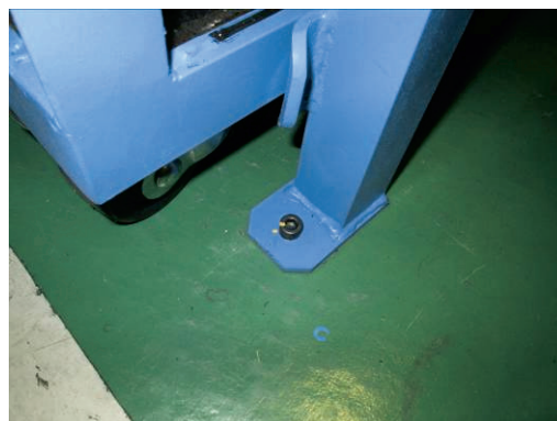
設備を固定するアンカーボルト (出所) NKSJ リスクマネジメント社 撮影
